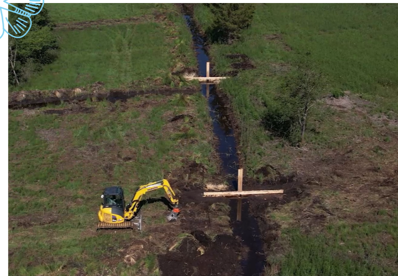
Mise en place de panneaux en bois avant comblement
