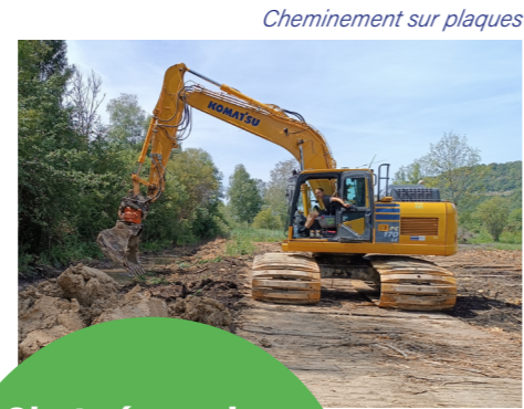
Cheminement sur plaques
