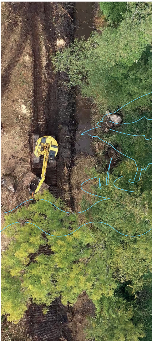
Comblement d'un fossé
