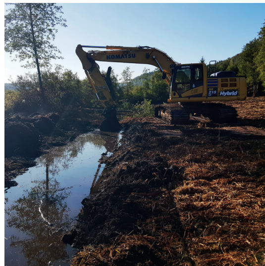
Comblement d'un fossé
